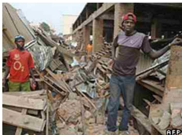
La devastazione del terremoto a Bukavu (RDC)
