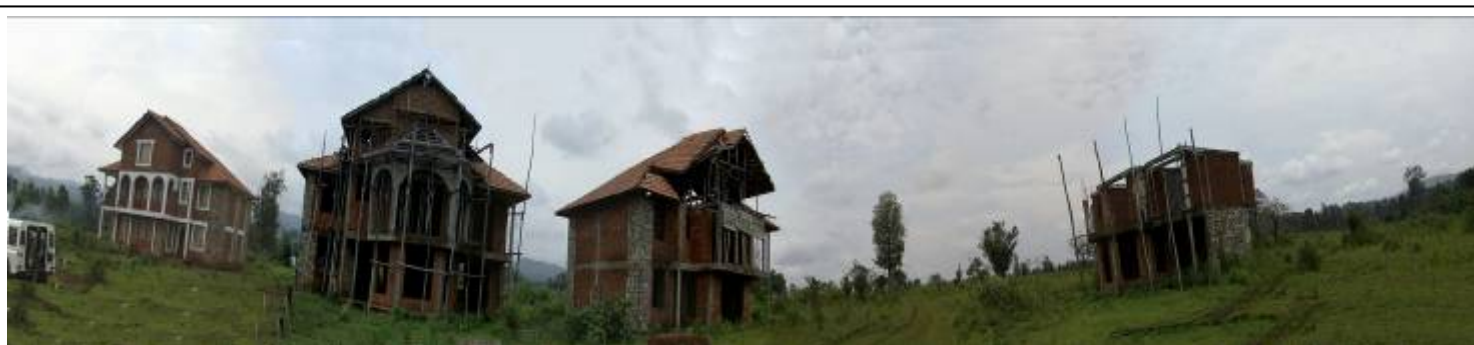
Vista del villaggio in costruzione "Mamma della Pace" di Nyakadaka dopo il terremoto (da sinistra casa donata da Diocesi Ischia., al centro casa donata da Baby nel Cuore)
